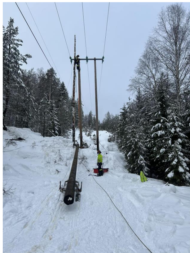
Stolpebytte på Voje, avvik oppdaget under årskontrollen av høyspentlinjene.
