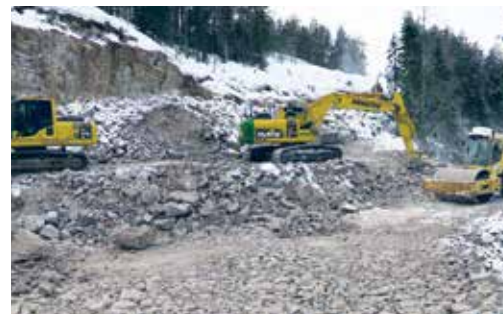
Utgraving av tomta til Nye Suvdøla Kraftverk. Foto Hans Fredrik Dale.
