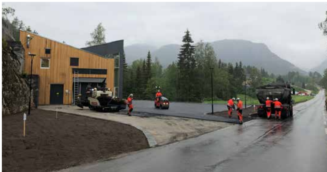
5. juni 2019. Anleggsarbeidet på Nye Suvdøla nærmer seg slutten. Everkets arkiv.
