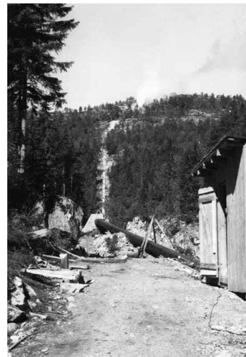
Rørgata 20. juni 1960. Det går en salve i forskjæringen. Foto Hans Edvin Haug.
