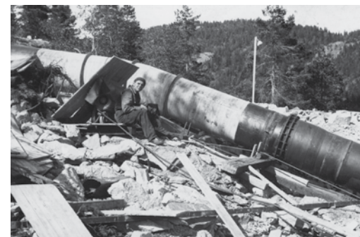
Sveiser Olsen på Toppen (av rørgata). Foto Hans Edvin Haug.
