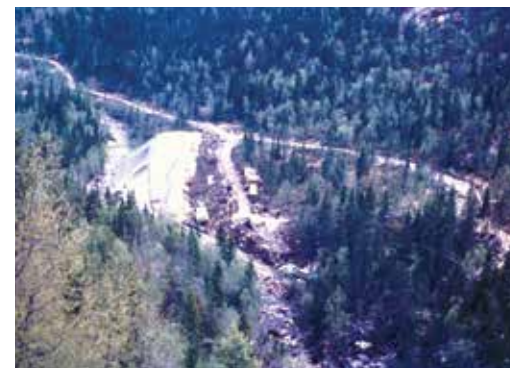
Tunnelinntaket på Nedre Borgja. Tunnelen sto ferdig høsten 1965. Foto Jon Odd Grave.
