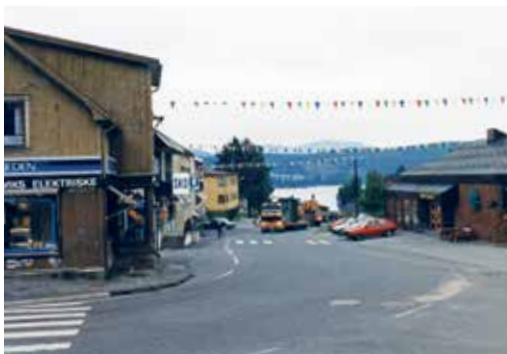
132/22 kV transformator fra Holtane, frakta med tog på Kragerøbanen 18.8.1988, og kjørt videre til Stemmen, her gjennom Drangedal sentrum. Everkets arkiv.
