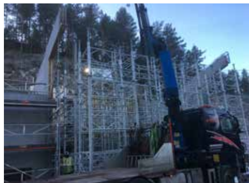
26.11.2018. Fra bygginga av Nye Suvdøla. Foto Hans Fredrik Dale.
