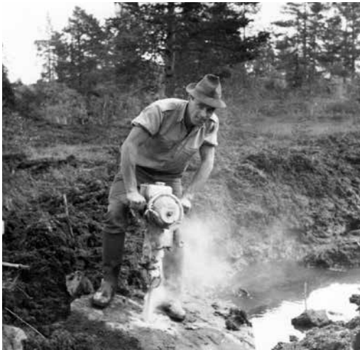
Knut Asbjørn Bø borer i grøfta der kanalen fra Måvatn til Steinbutjenna skal gå. Foto Jon Odd Grave.
