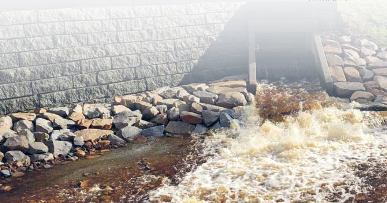
Utløpet av Nye Suvdøla Kraftverk. Everkets arkiv.
