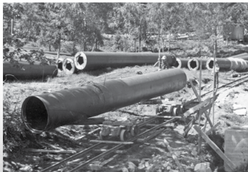
Rørlageret på Bakkane. Foto Hans Edvin Haug.
