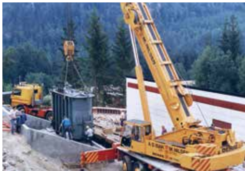
Transformatoren fra Holtane løftes på plass i Drangedal transformatorstasjon 18.8.1988. Everkets arkiv.
