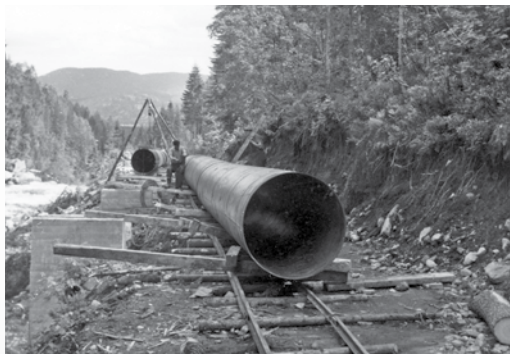
Tre rørlengder sveises sammen og rulles ut på klossene. Foto Hans Edvin Haug.
