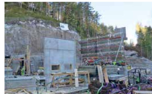
Fra oppstart bygging av kraftverket på Bø i Tørdal. Foto Hans Fredrik Dale.
