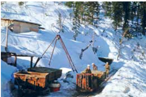
Tunneluttaket på veien opp mot Borgja. Foran Per Kleiv, Gunnar Lia, og Halvor Hagen bakerst. Foto Jon Odd Grave.
