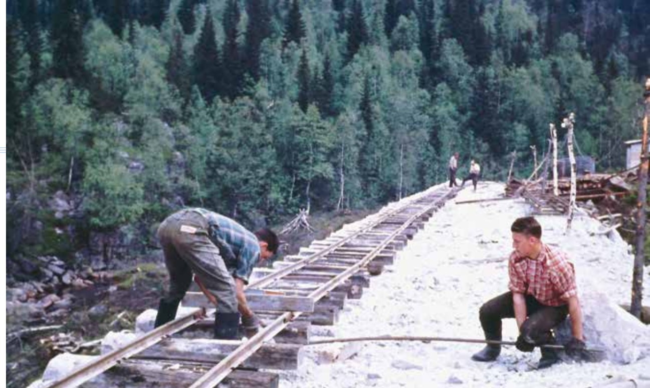
Tunnelinntaket på Borgja. Foran.f.v. Knut Asbjørn Bø, Per Kleiv. Bak.f.v. Halvor Hagen, Gunnar Lia. Foto Jon Odd Grave.
