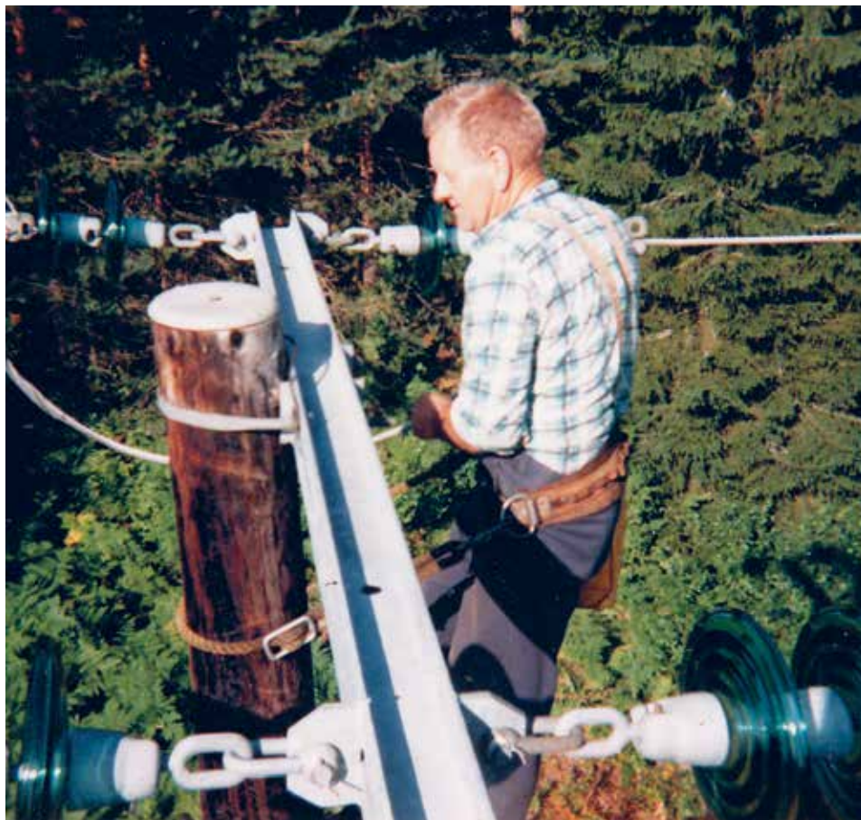
3. august 1983. Toppbefaring av hovedlinja. Her er Nils E. Hegna i arbeid. Foto Gunnar Elefskås.
