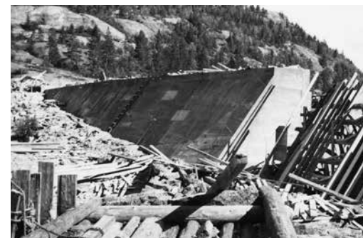
Massivdam øst Kleppsvann. Ferdig støpt ca. 1. september 1959. Foto Hans Edvin Haug.
