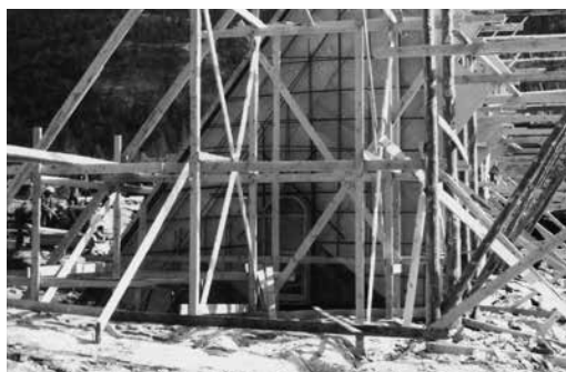
Armering av pilar. Kleppsvann, ca. 1. august 1959. Foto Hans Edvin Haug.
