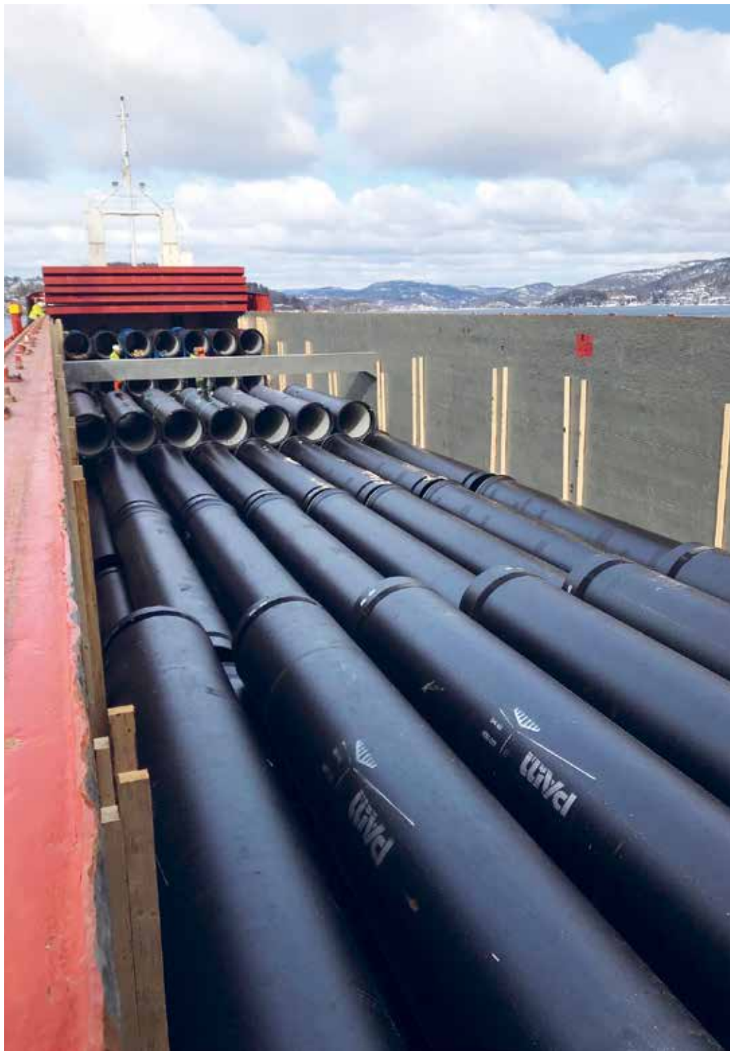
Nye Suvdøla Kraftverk 15.03.2018. Grenland Havn i Brevik, båtankomst fra Frankrike med alle rørene til Nye Suvdøla Kraftverk. Everkets arkiv.
