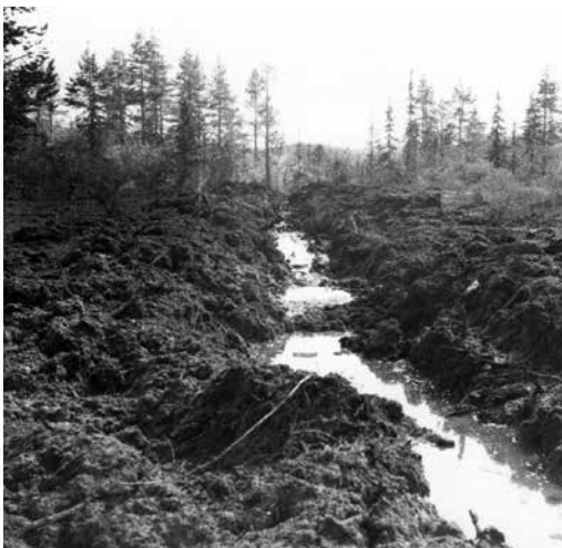
Grøfta i Stordalsmyra. Denne blei sprengt med grøftedynamitt. Foto Knut Asbjørn Bø.
