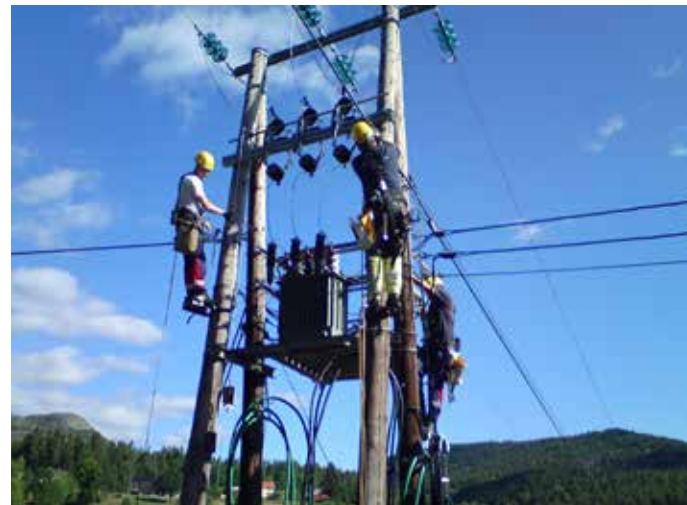
Jobb i mastearrangement 9. juli 2010, i forbindelse med omlegging til bakkebetjente nettstasjoner. Foto Arve Øystein Naas.
