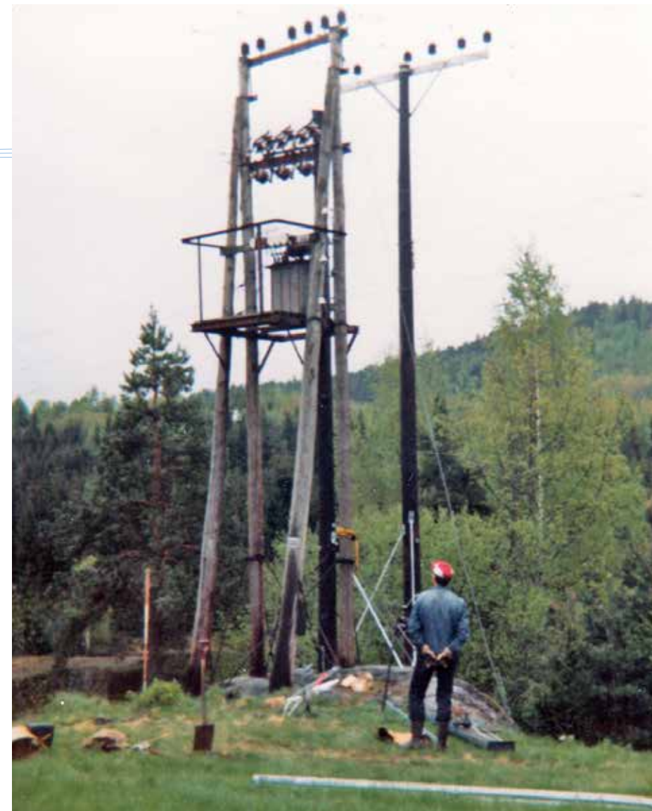
26. mai 1983. Den gamle trafo på Øvre Vefall står for fall. Erling Odden tar et siste blikk før den går i bakken. Foto Gunnar Elefskås.
