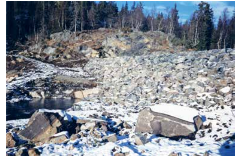
Måvassdammen etter ombygging 5.11. 1990. Everkets arkiv.
