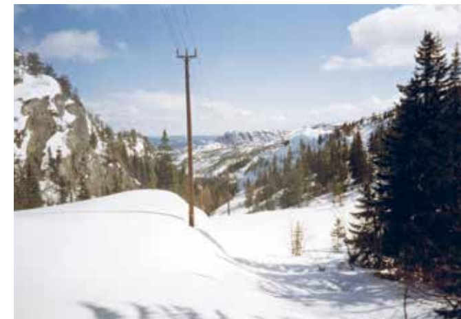
Linja Suvdøla – Nissedal vinteren 1994, nedover lia mot Suvdøla Kraftverk. Everkets arkiv
