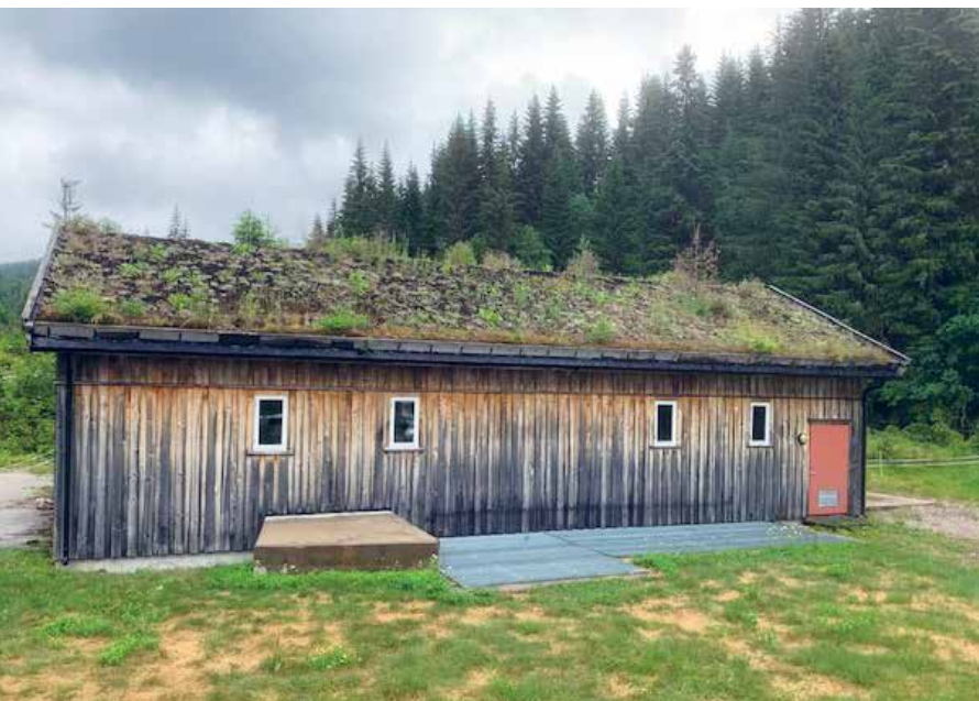
Suvdal kraftstasjon, som sto ferdig i 2004. Bildet er tatt sommeren 2020 av Runar Kleiv.
