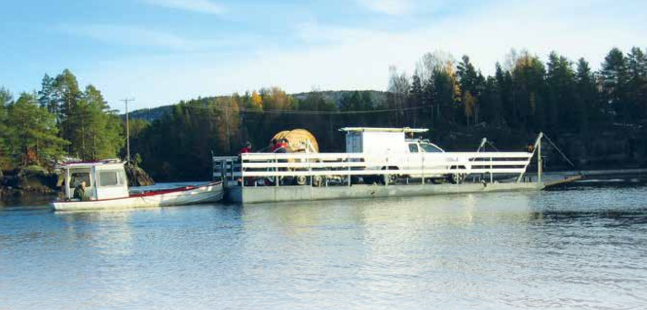
Fiberfremføring i Toke. Skipper Knut Olav Sannes med ferge bistår Drangedal everk. Everkets arkiv.
