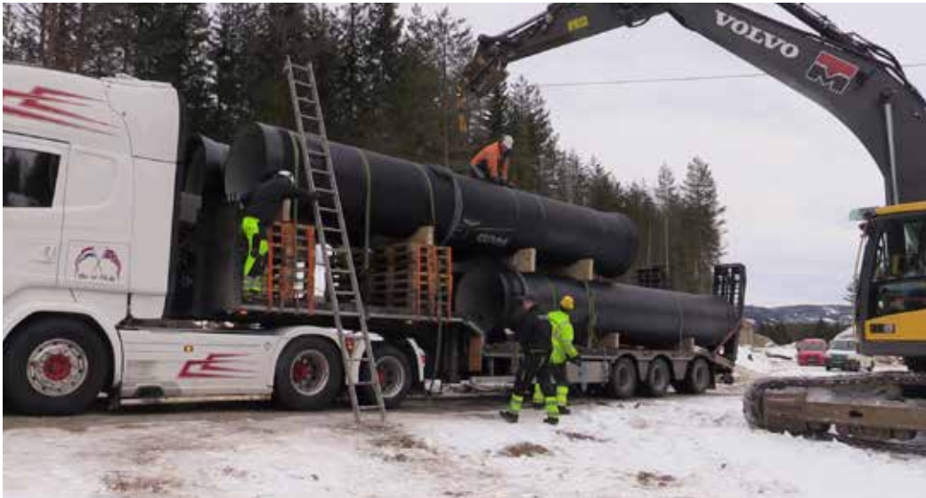
Røra ankommer byggeplassen. Foto Hans Fredrik Dale.
