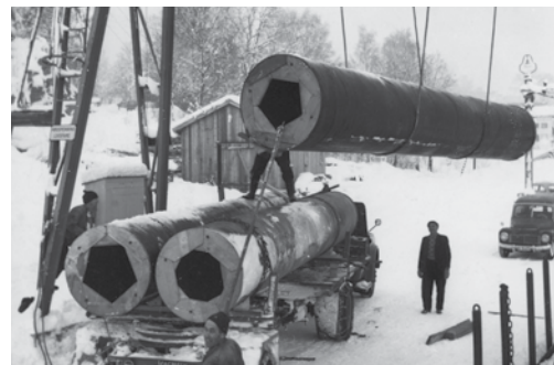
Rør lastes på Drangedal stasjon februar 1960. Foto Hans Edvin Haug.
