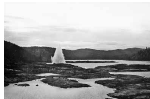
Gjennomslagssalva i tappetunnelen 22. oktober 1959. Foto: Hans Edvin Haug.
