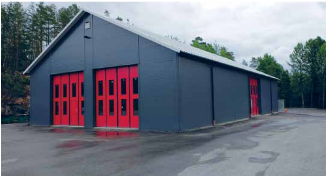
Nytt lagerbygg, «kaldblager», ferdig i 2014. Foto Anne Kjendsheim.
