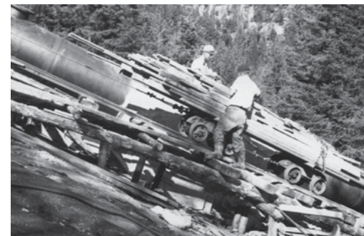
Materialtransport i rørgata ved kloss 7. Foto Hans Edvin Haug.
